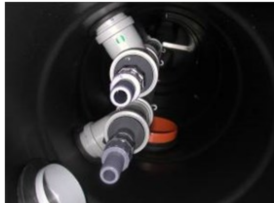
Imagen 8: Vista General de conexiones de sistema de aireación y recirculación Microstep.
