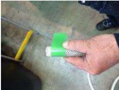
Cortar tramo de manguera DN16 e identificar con etiqueta verde.
