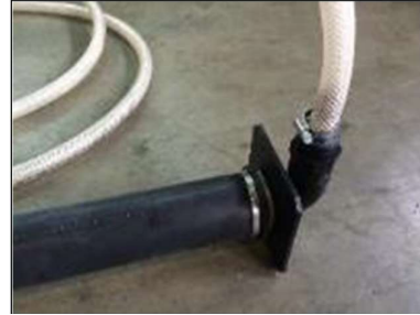
Cortar tramo de manguera DN16 y unir al entronque del difusore por medio de una abrazadera.
