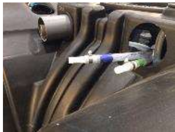
Pasar el tramo de tubería por el orificio DN110 con la etiqueta (SALIDA MANGUERAS A CUADRO DE CONTROL).
