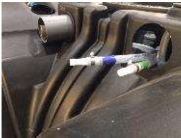
Pasar el tramo de tubería por el orificio DN110 con la etiqueta (SALIDA MANGUERAS A CUADRO DE CONTROL).
