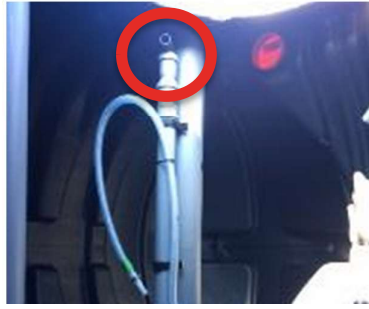
Reconocer entronque negro del Air Lift del Digestor.
