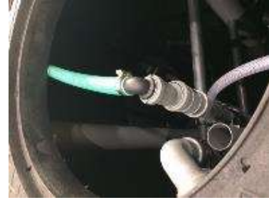
Conectar, mediante abrazadera Inox 25-40, el tramo de manguera DN30. Pasar esta tubería corrugada a través de los agujeros con "Paso de Mangueras" hasta el Decantador 1 MS.
