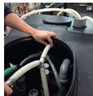
Imagen 10 Unión de las mangueras de los difusores en el depósito digestor, grifo de regulación y salida de mangueras
