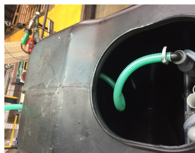
Imagen 5 Manguera corrugada en entronque del Air-Lift. Sale del depósito por el lateral hacia el depósito contiguo.
