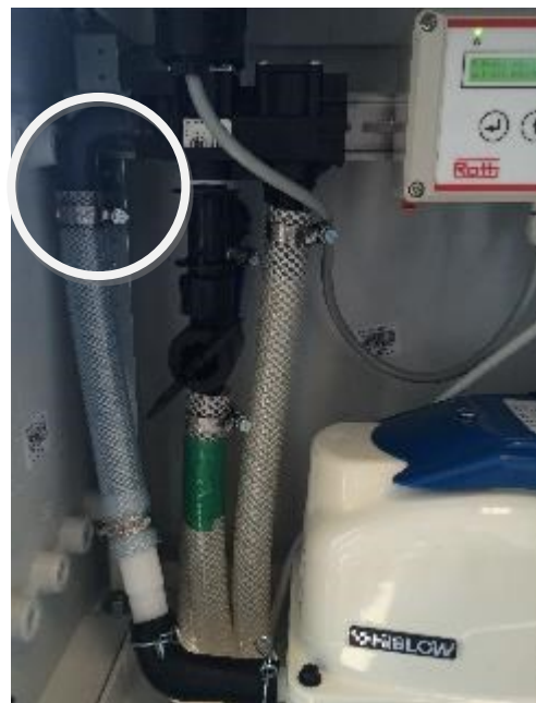
Imagen 14 Conexión de la soplante. Se conecta a la salida Izquierda de la válvula 4V.
