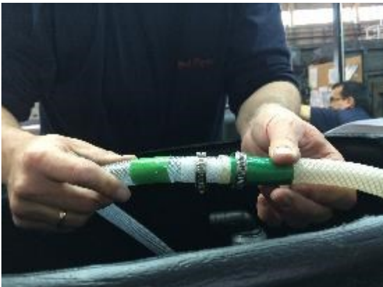
Imagen 4 Conexión de la manguera que irá al cuadro eléctrico con la manguera del Air-Lift
