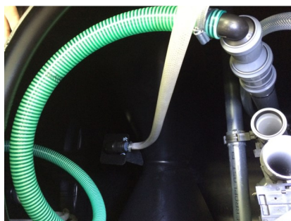
Imagen 9 Instalación de los difusores en el depósito decantador y digestor
