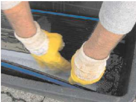
Fotografía 10: Mantenimiento y limpieza de membranas.
